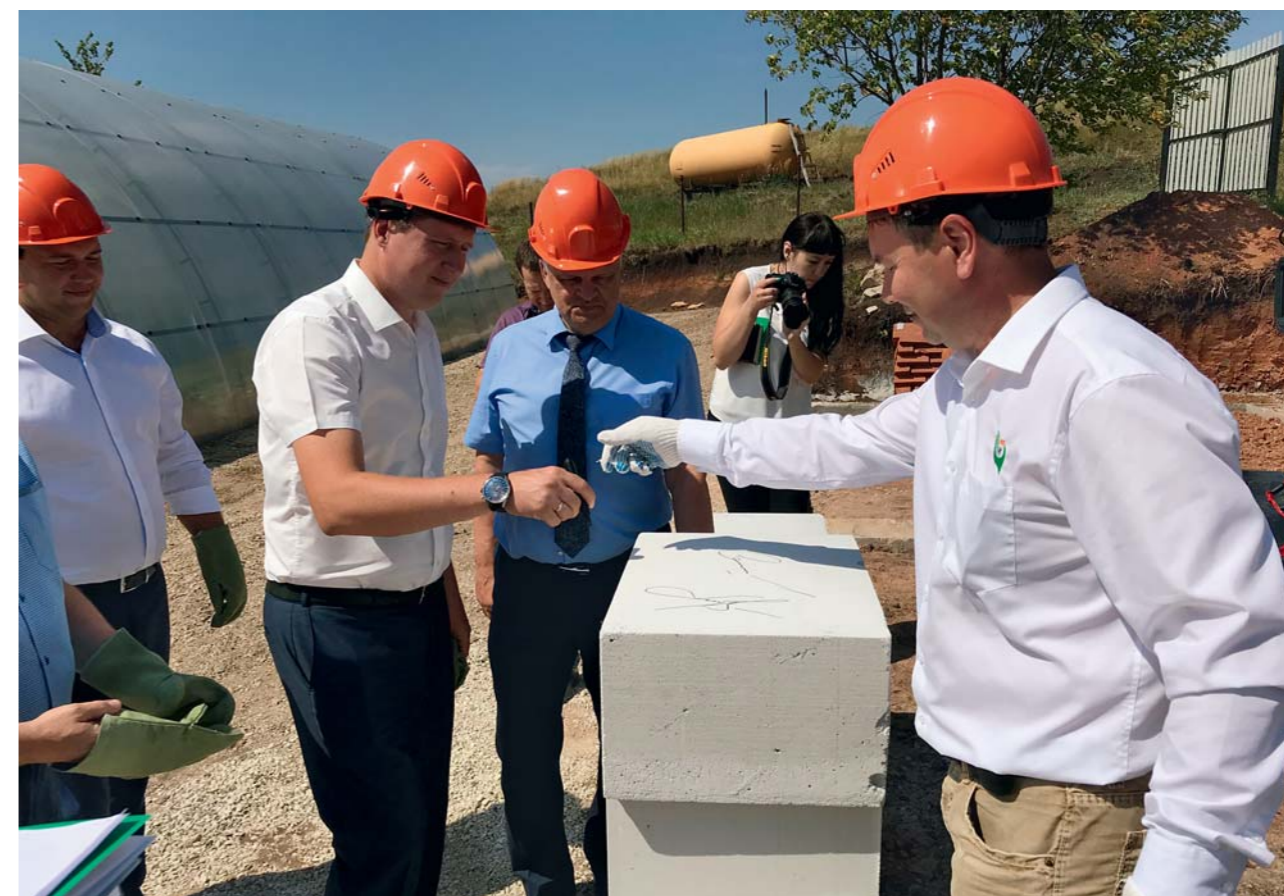
Закладка первого блока под будущую селекционную лабораторию.
